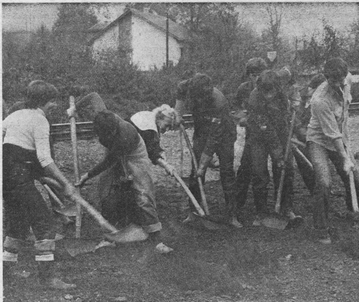
A kad je došao voz svi su prionuli, istovarali vagone i ugrađivali šijunak u trasu drugog kolosijeka
