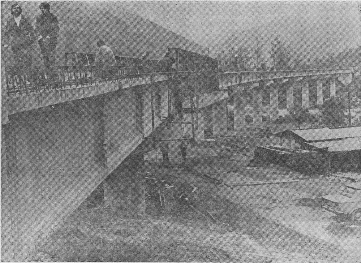
Крај дјело краси: носачи су повезали стубове, а при крају је и постављање плоче на носачима
