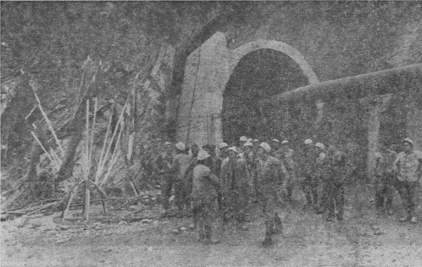
Vranduk je probijen, izvađeno je srce iz planine a sada brigadiri i radnici ŽEGRAP-a privo de kraju betoniranje
