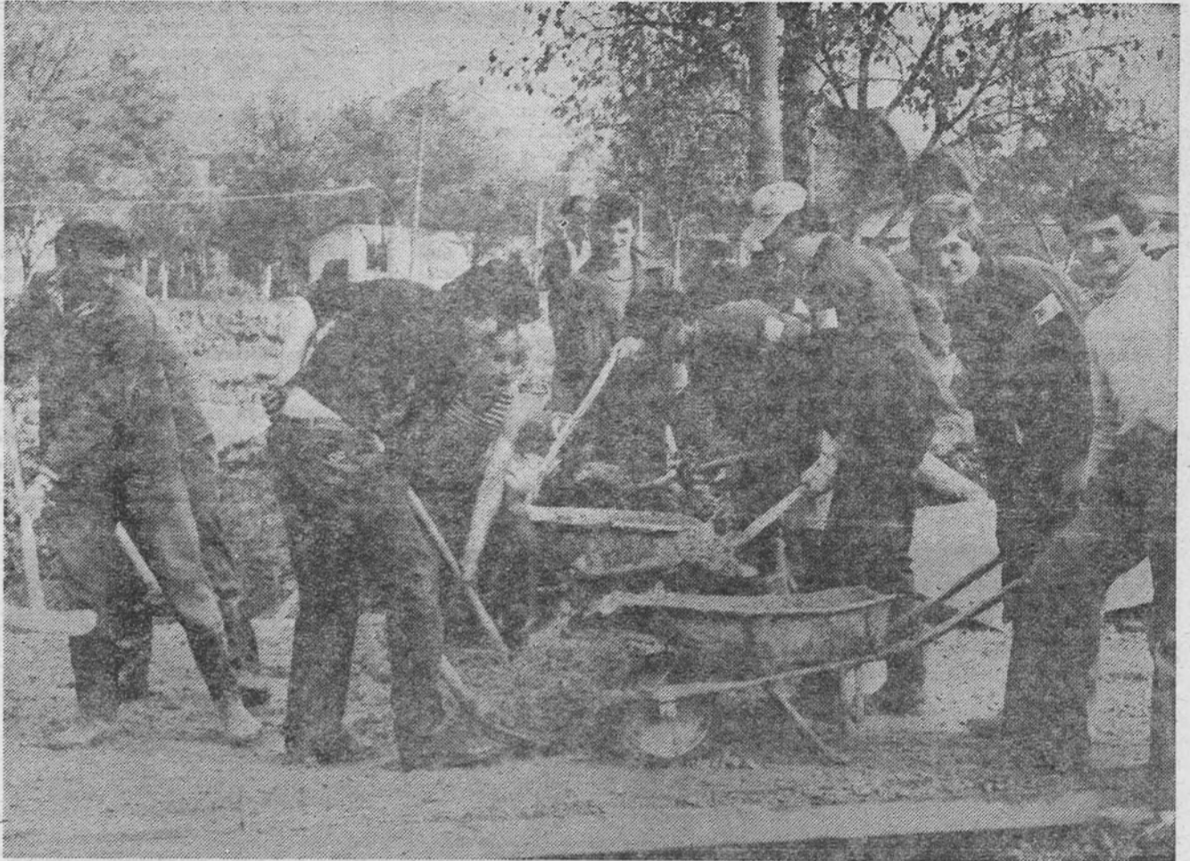
Измијешани шљунак и цемент не смије дуго да чена, треба га што прије уградити — подвонњан направити
