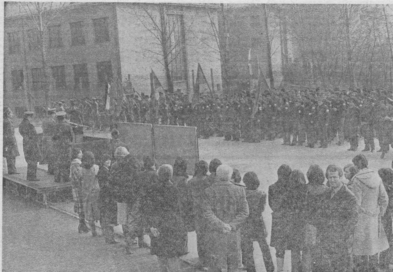
General-major Anton Lukežić čestitao vojnicima za izvanredne rezultate postignute na izgradnji drugog kolosijeka u sedmoj i osmoj smjeni
