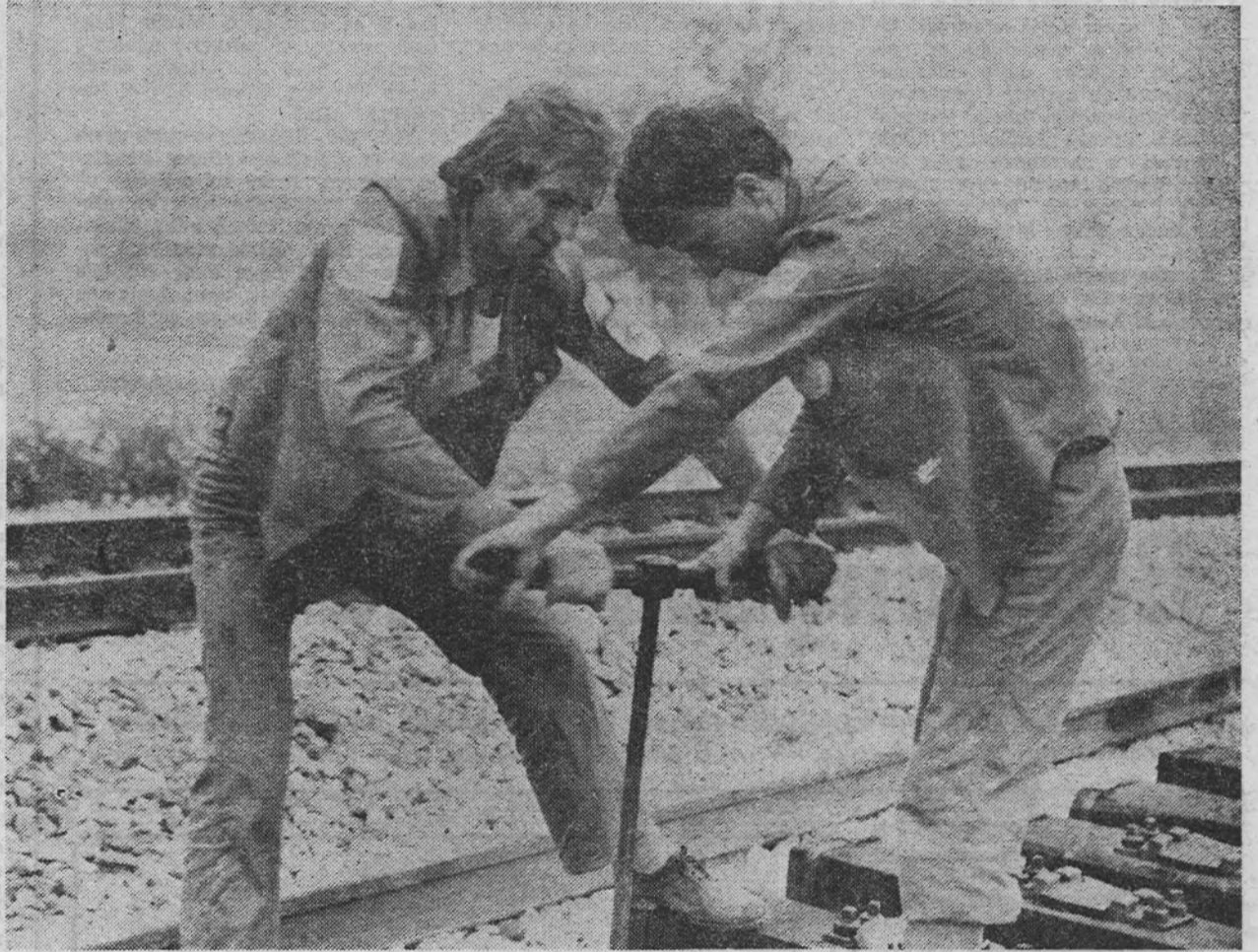
На ред су дошли последњи километри пруге — бригадири причвршћују шине
