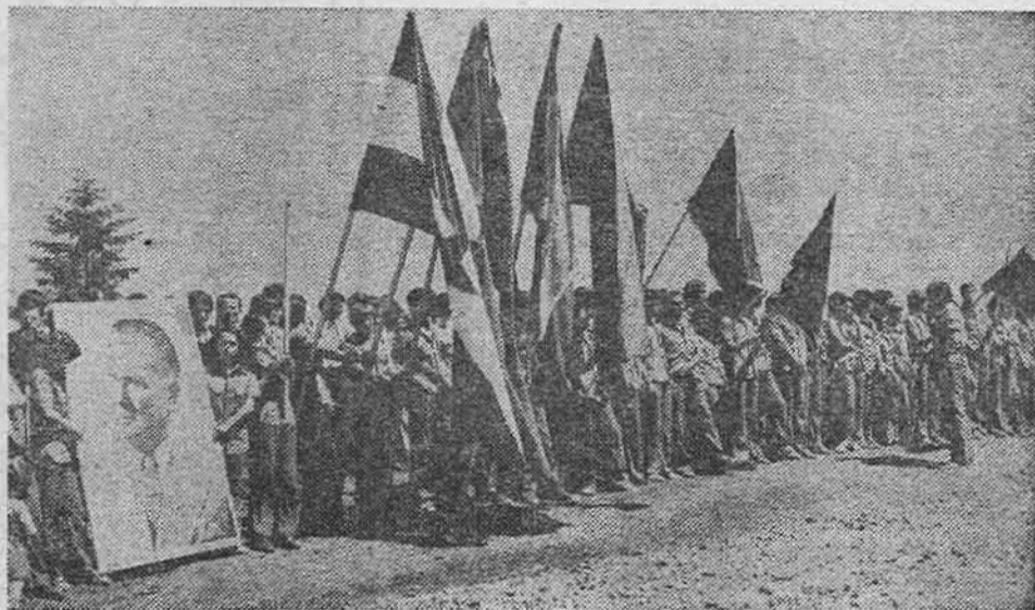
Brigada »Dragan Bubić« uoči polaska na izgradnju pruge
