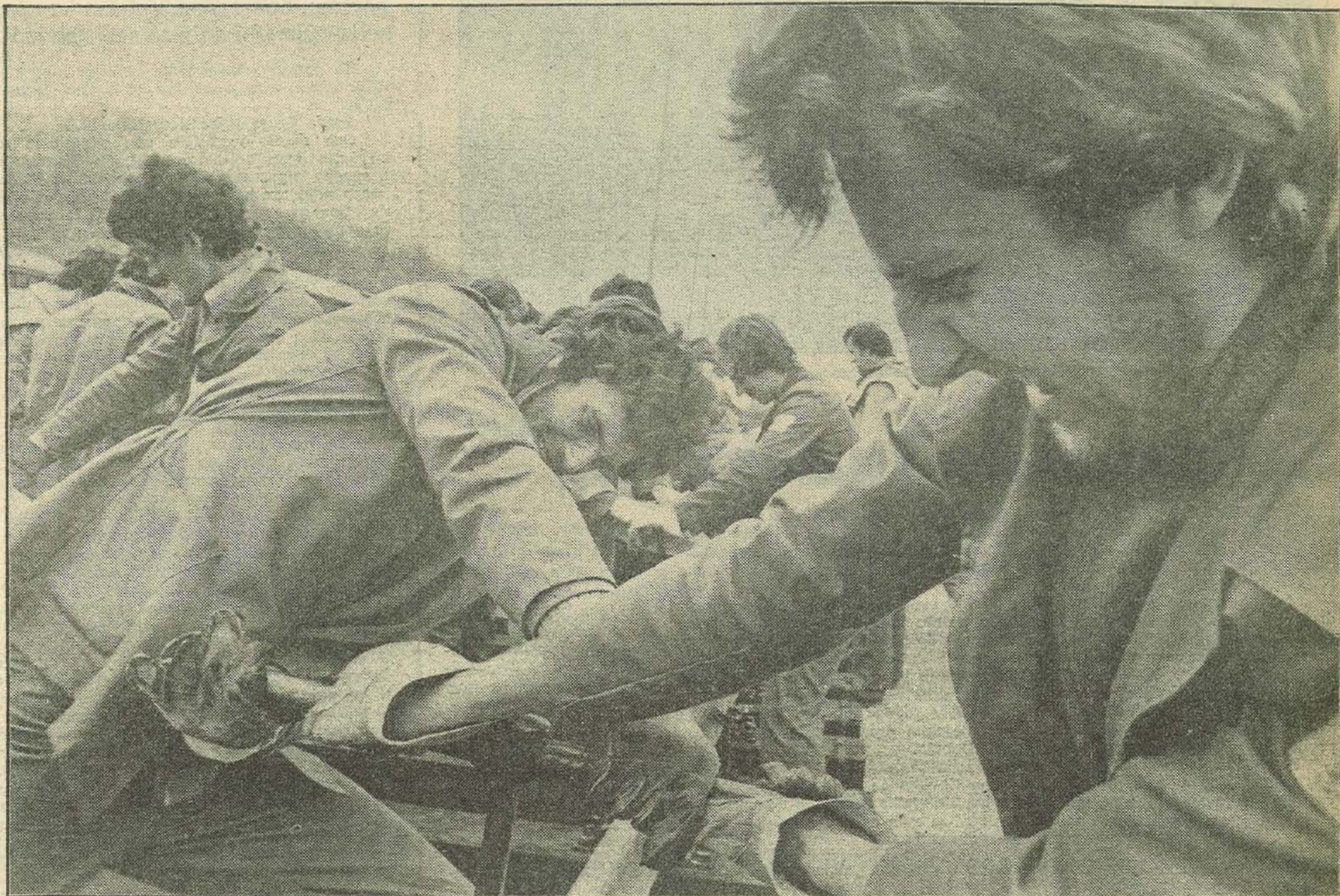
Još se priča o naporu Devete udarne brigade koja je postavila prve šine drugog kolosijeka: lica brigadiru potvrđuju riječi hvale
