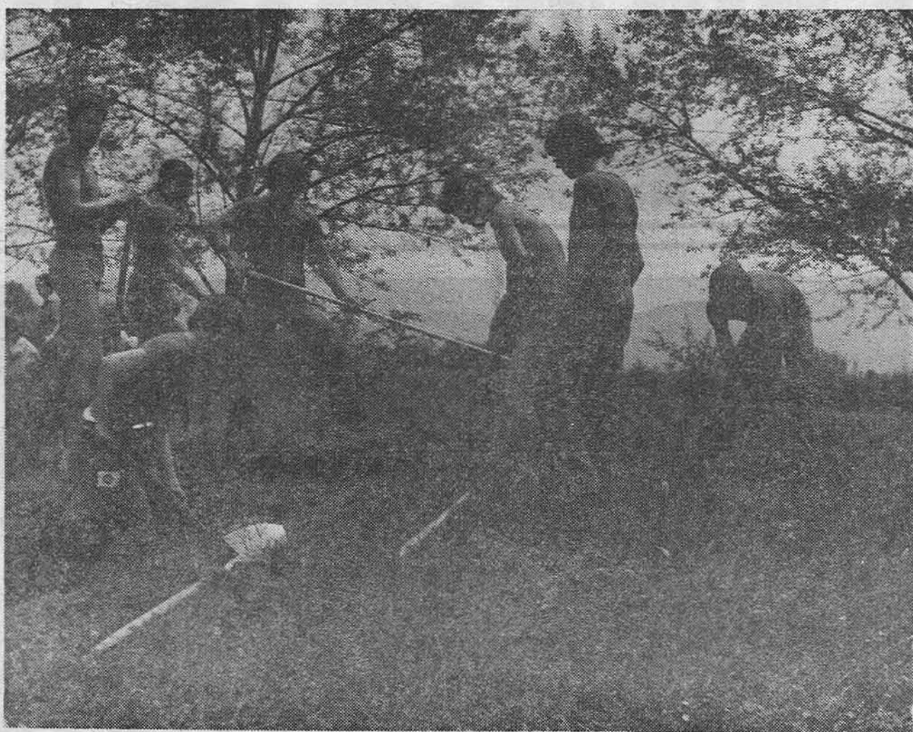
Iskopan kanal za električni kabl
